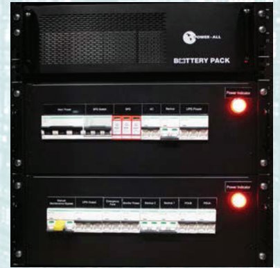
Módulos de distribución de energía
