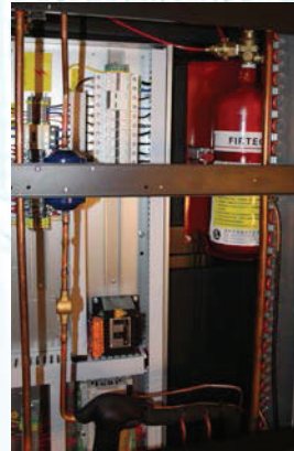
Sistema contra incendio
