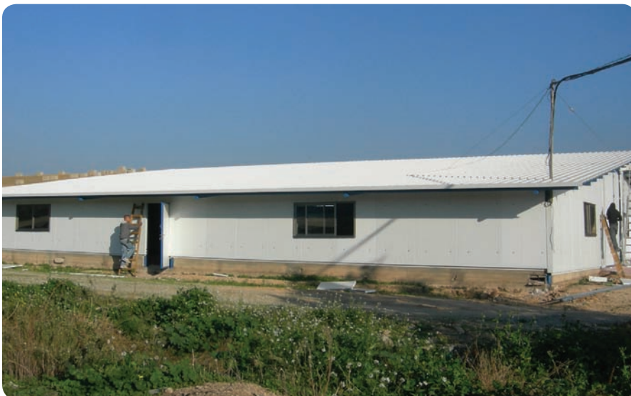
כיסוי גג מסגריה בקיבוץ עברון. פנל גג עם מילוי פוליסילבר, קירות פנל קלקר. ביצוע: חב' אהרון יגאל הנדסת בניין בע"מ
