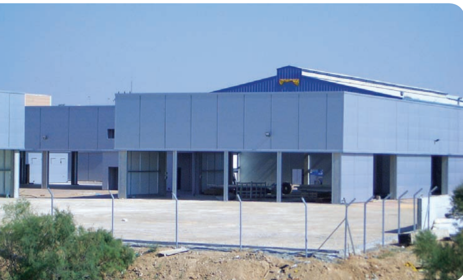
מוסך מזדה באר-שבע. פאנל קיר חיבור נסתר ופאנל גג.
